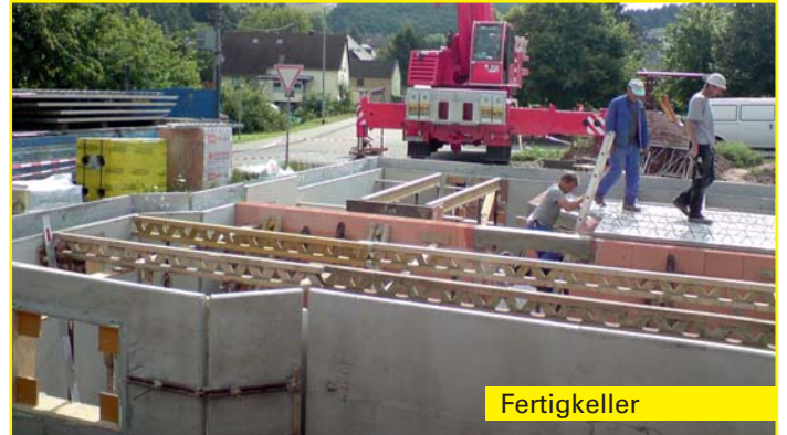
Neubau eines Einfamilienhauses
